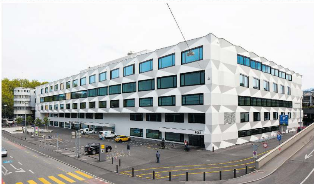
Das Zürcher Architekturbüro Enzmann Fischer baute 2011 das ehemalige Postgebäude beim Luzerner Hauptbahnhof zum Sitz der Pädagogischen Hochschule der Universität Luzern um und richtete dabei hinter der wabenartig gefalteten Fassade im östlichen Lichtof eine stilvolle Dependence der Zentral- und Hochschulbibliothek ein.
