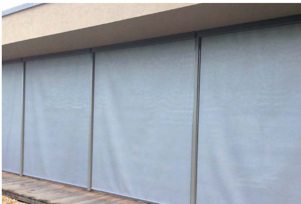
Bild 9.4.6 V-förmige Wellen
