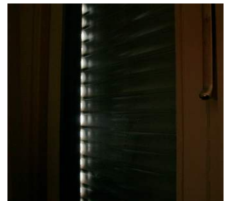
Abbildung 16: Zulässiger Lichteinfall über die Führungsschiene. ▶
