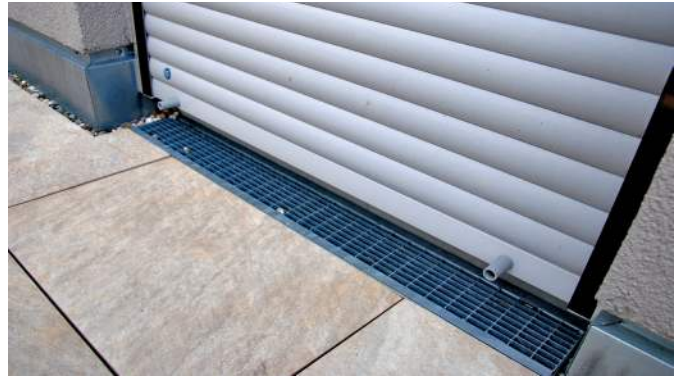
Abbildung 3: Führungsschienenabschluss stellt waagerechtes Auflager für den Rollladenpanzer dar. Der Bodenbelag und die Entwässerungsrinne wurden zu einem spätern Zeitpunkt eingebaut.
