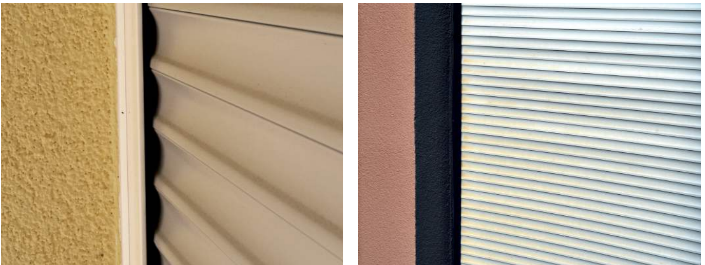
Abbildungen 28 + 29: Ablagerungen aus Staub, Pollen und weiteren Umwelteinflüssen, die sich mit der Zeit auf der Oberfläche der Stäbe „eingebrannt“ haben.
