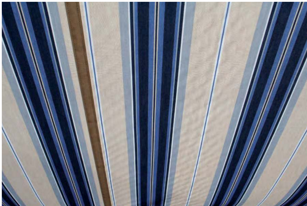
Bild 9.1.10 Zulässige Welligkeit im Bahnbereich (Wabenbildung)
