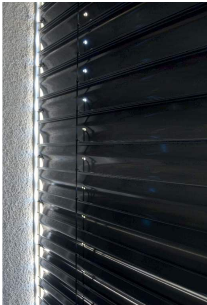
Image 6 : Entrée admissible de lumière diffusée via le guidage latéral
