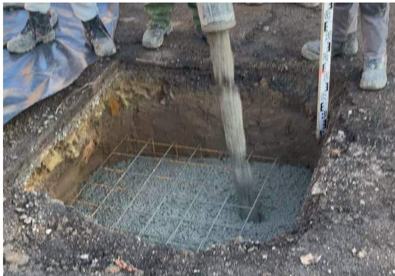
Abbildung 11: Beispiel der Einbringung von Transportbeton C25/30 mit einer Betonpumpe (Bildrechte OV)
